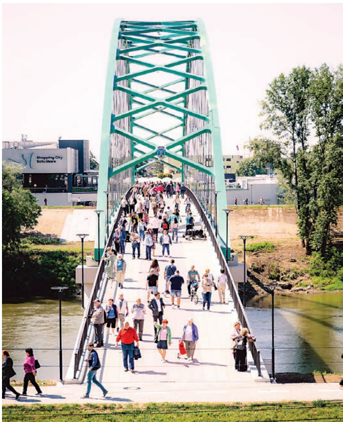
Die Fußgängerbrücke ist eines der größten Bauwerke dieser Art in Rumänien, mit einer Länge von 214 Metern, wobei die Stützen nur am Ufer stehen. Foto: Rathaus Sathmar
