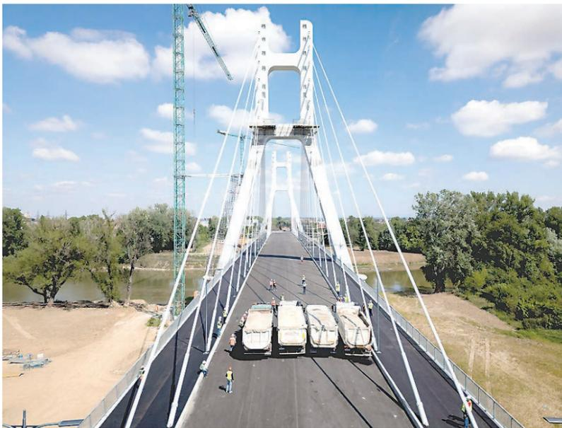
Der erste Test an der Schrägseilbrücke über den Fluss Samisch
